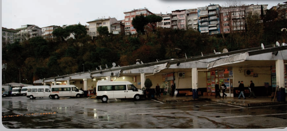
Harem'de çatıların çökme tehlikesi hala devam ediyor.
