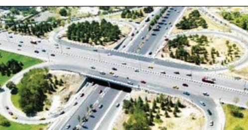
nedeniyle yapımı bir süre durdurulan Çağlayan Köprüllü Kavşağı'nın sebebiyle yapım işinin aksaması, bunların aşılmasının hemen ardından
